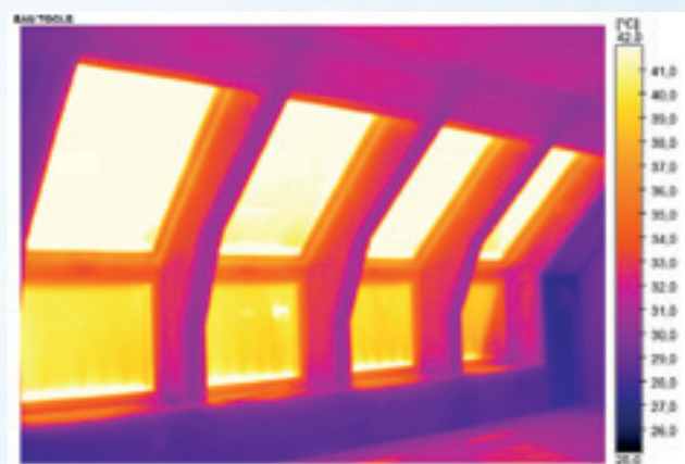
Thermogramme final : Les différences entre le thermogramme de départ et le thermogramme final ne sont pas visibles
