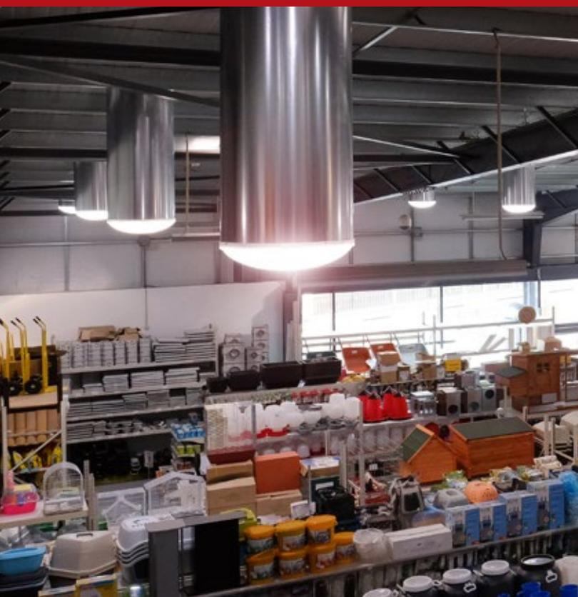
Ce sont des systèmes écologiques où la lumière naturelle est capturée et guidée en utilisant un tube revêtu, intérieurement, par un matériau ultra-réfléchissant qui minimise la dispersion des rayons du soleil et permet un approvisionnement de la lumière sur des distances considérables sans transmission de chaleur ou de froid.
