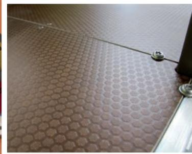
Panneaux en Stratifié-compact (HPL), épaisseur 13 mm, qualité extérieur, deux faces papier décor intégrées dans la masse, traitement anti-UV et traitement anti-graffiti.
