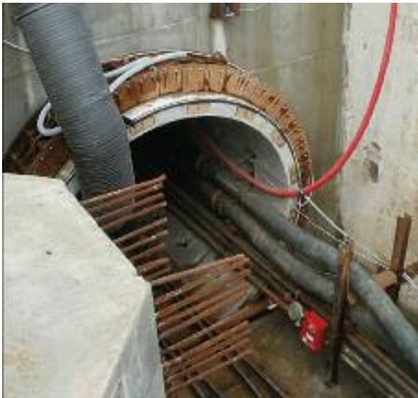
Exemple d'un projet de construction de tunnels utilisant des Décanteurs Flottweg
