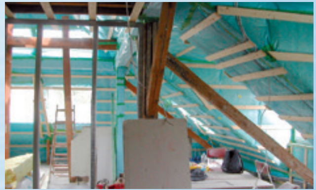
La mesure BlowerDoor pour la démarche qualité pendant la construction
