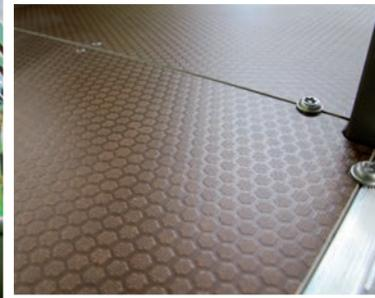
Panneaux en stratifié-compact (Stratifié-compact (HPL)), épaisseur 13 mm, qualité extérieur, traitement anti-UV et traitement anti-graffiti.
